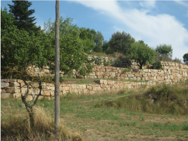
Mur de contenció de grans blocs a Calders Antics murs de pedra seca a Santa Maria d'Oló
