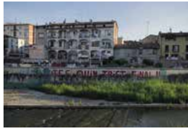
022_ Canalització del riu Ges Canalización del río Ges / Ges river channelization / Canalisation de la rivière Ges Torelló Oriol Clavera
