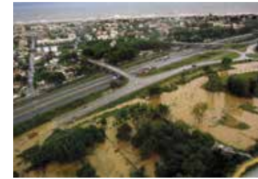
036_ Inundació Inundación / Flooding / Inondation Castelldefels David Airob
