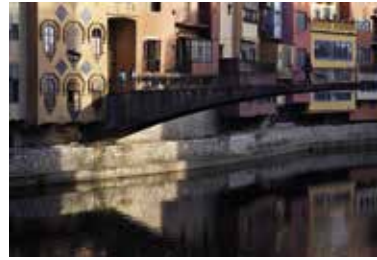
109_ Façana fluvial del riu Onyar / Fachada fluvial del río Onyar / Onyar riverside façade / Façade fluviale du fleuve Onyar Girona Oriol Clavera
