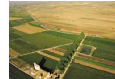
045_ Canal d'Urgell Canal de Urgell / The Urgell Canal / Canal d'Urgell Vilanova de Bellpuig Jordi Bas
