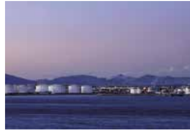
108_ Complex petroquímic i port de Déu del Carme / Complejo petroquímico y puerto / Petrochemical complex and port / Complexe pétrochimique et port Tarragona Rafael López-Monné
