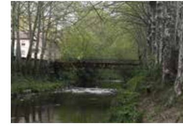
032_ Pont de Colom sobre el riu Fluvià Puente de Colón sobre el río Fluvià / Columbus bridge over the river Fluvià / Pont Colón sur le fleuve Fluvià Olot Pep Sau
