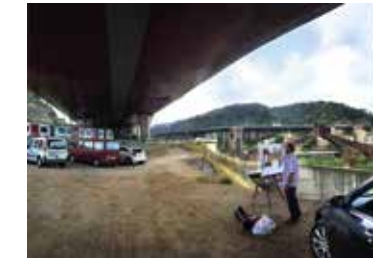
039_ Ponts sobre el riu Llobregat Puentes sobre el río Llobregat / Bridges over the Llobregat river / Ponts sur le fleuve Llobregat Martorell Carma Casulá
