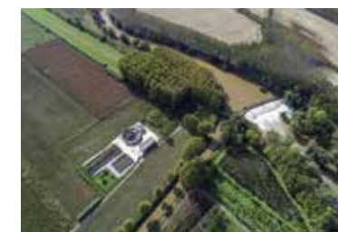
013_ Depuradora al marge del riu Ter Depuradora en la orilla del río Ter / Sewage plant beside the Ter river / Station d'épuration et fleuve Ter Flaçà Paisatges Verticals
